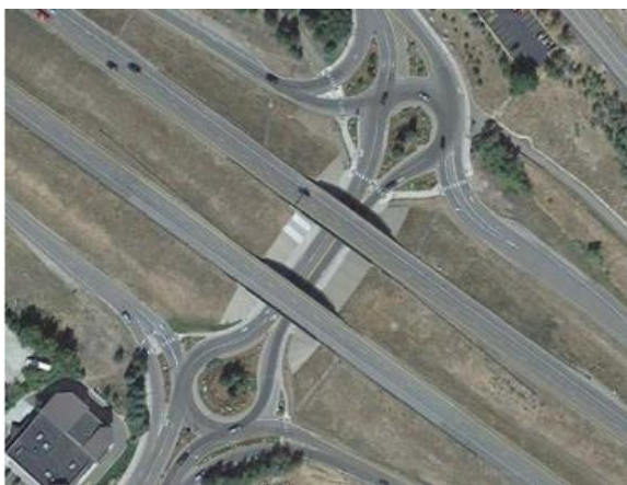
Рис. 4. ПРК як елемент ромбічної транспортної розв'язки на сполучних зонах з'їздів, згідно з [4]
