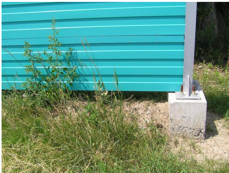
Рис. 6. До неправильного встановлення шумозахисних екранів (велика відстань між нижньою частиною екрана та поверхнею ґрунту)
