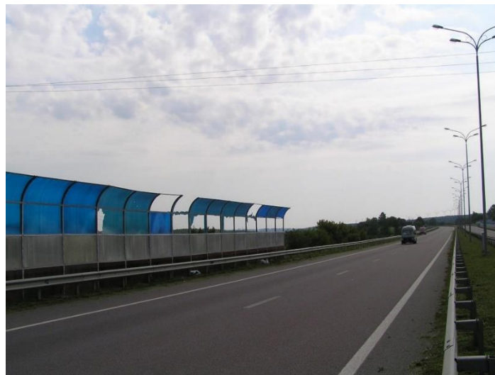
Рис. 5. До проблем існуючих шумозахисних екранів (поламки від впливу сонячної радіації)
