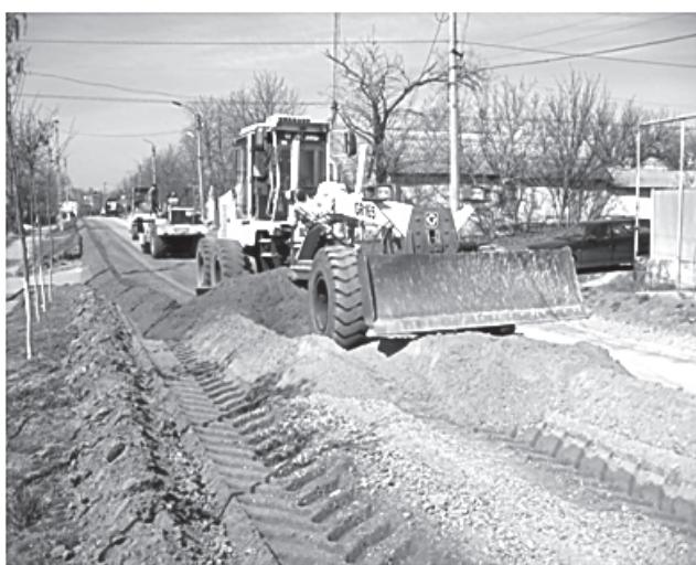
*Рис. 7. Профілювання автогрейдером поперечного профілю дорожнього одягу на всю ширину*
