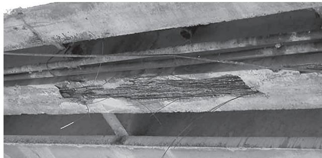
*Рис. 3. Прогонова будова за типовим проектом "ВТП-15". Розрив струн робочої поздовжньої арматури в нижньому поясі балки прогонової будови (міст через р. Горинь на автомобільній дорозі Р-48 Кам'янець-Подільський-Сатанів-Вйтівці-Білогір'я на км 159+524)*
