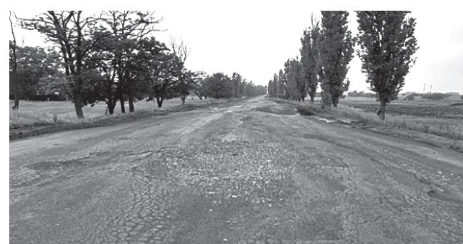
Рис. 1. Руйнування нежорсткого дорожнього одягу переходного типу
