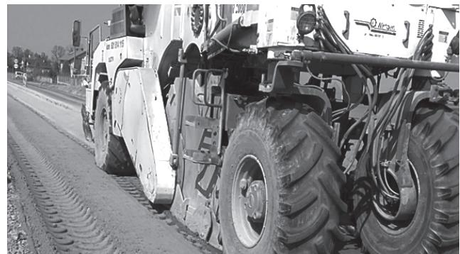
Рис. 3. Ресайклер-стабілізер на самохідному шасі [12]
