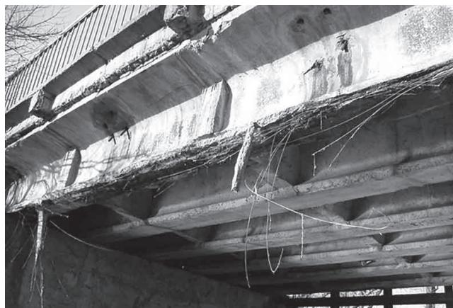
*Рис. 2. Прогонова будова (за типовим проектом "ВТП-15") складається із збірних залізобетонних балок з попереднім натягом струнної арматури. Значна частина робочої арматури оголена, схильна до корозії, кілька стрижнів (струн) обрівани. Несна здатність балки значно знижена (міст через р. Роставиця на автомобільній дорозі Н-02 /М-06-/Кременець-Біла Церква-Ржищів-Канів-Софіївка на км 375+787)*
