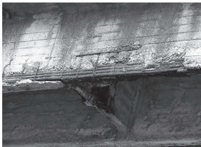
*Рис. 1. Прогонова будова за типовим проектом "Випуск 56". Руйнування захисного шару нижнього поясу балки і корозія робочої арматурі (шляхопровід через залізничну колію на автодорозі міжнародного значення М-12 Стрий-Тернопіль-Кропивницький-Знам'янка (через м. Вінницю) на км 524+232)*
