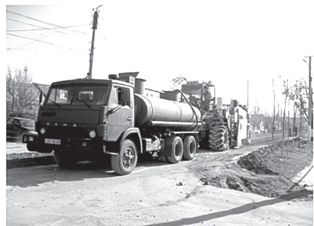
*Рис. 6. Фрезерування (розпушування) і перемішування з цементом матеріалів існуючого дорожнього одягу*
