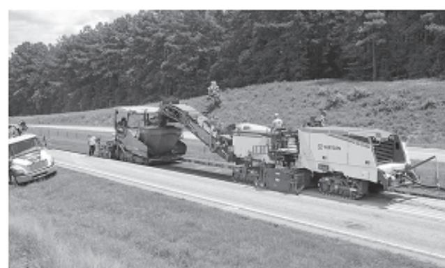
*Рис. 2. Робота ресайклера, який одночасно з виготовленням суміші влаштовує шар за допомогою асфальтоукладальника [1]*
