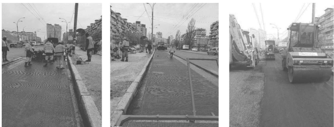
**Рис. 9.** Ремонт місць зупинок громадського транспорту в м. Києві із застосуванням ACM Adfors GlasGrid CG100, 2020 рік
