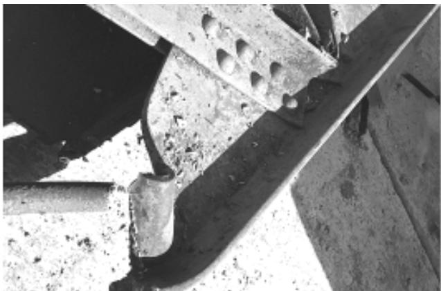
Рис. 5. Ділянка пластичного шарніру нижнього пояса низової ферми (тавр розрізано вже у процесі демонтування)
