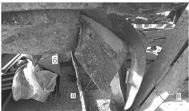
Рис. 6. Середня ферма, розрив верхнього пояса: а – стінка тавра; б – полка тавра; в – опорний розкос
