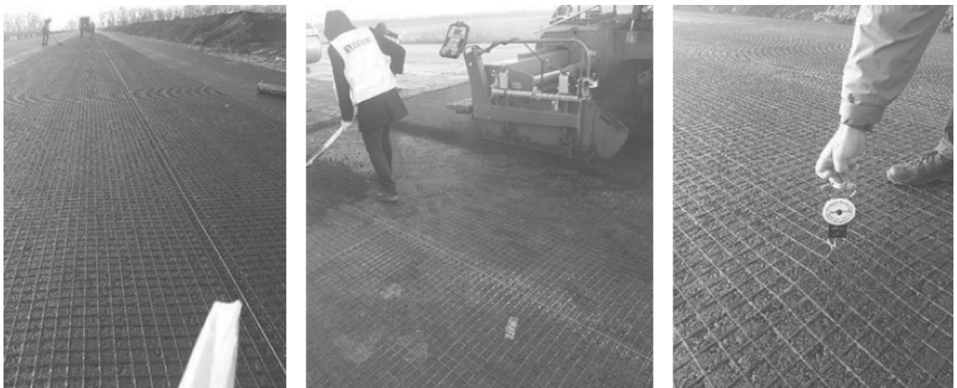
**Рис. 4.** Застосування ACM Adfors GlasGrid GG50 для виконання капітального ремонту автомобільної дороги М-03 Київ – Харків – Довжанський, 2019 рік
