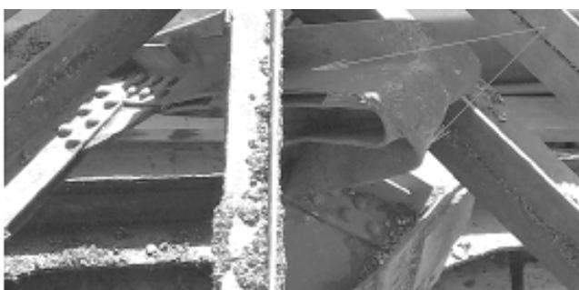
Рис. 7. Стрілкою відмічена деформація опорного розкосу верхової ферми
