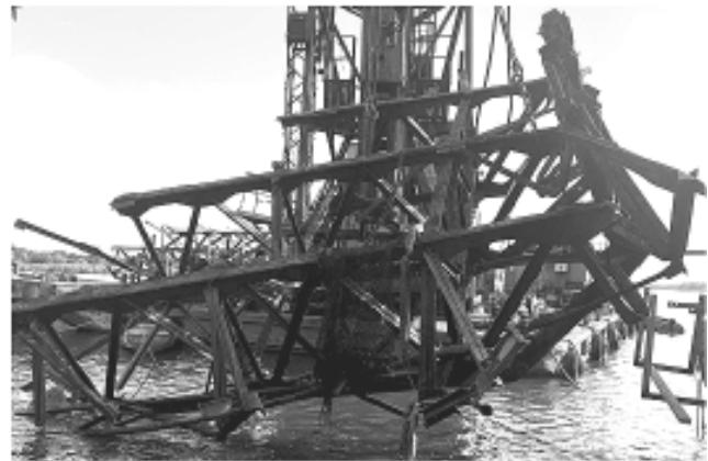
Рис. 3. Підйом із води крайньої до опори 4 секції прогонової будови
