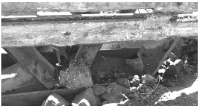
Рис. 4. Стрілкою позначена деформація нижнього пояса верхової ферми
