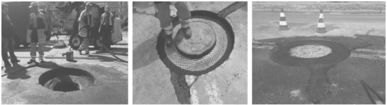
*Рис. 10. Застосування ACM Adfors GlasGrid PM100 для виконання ремонту зон каналізаційних люків у м. Києві, 2019–2020 роки*
