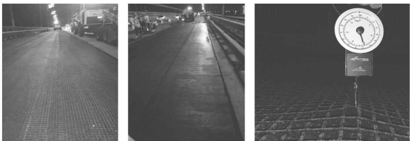
**Рис. 8.** Застосування ACM Adfors GlasGrid GG50, GG100 ma CG100 під верхнім шаром асфальтобетонного покриття на Південному мосту в м. Києві, 2019–2020 роки
